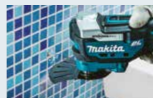
Cắt đường nối tường gạch
