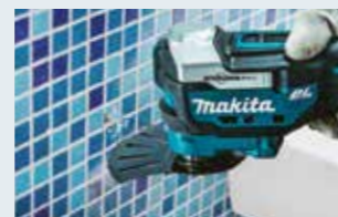
Cắt đường nối tường gạch
